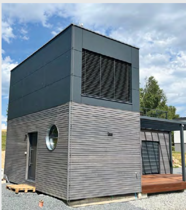
Konstrukce dřevostavby s fasádním obkladem Hardie® Plank
